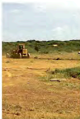
Trabajos dentro del P.N. medanos de Coro
